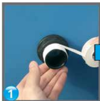
Etanșarea cu teflon sealing/ изоляция тefлоном
