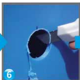
6 Se debavurează gaura finishing the hole/ обрезка
