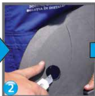
Se debavurează gaura finishing the hole/ обрезка
