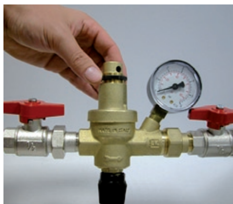
Allentare la ghiera in plastica Loosen plastic lock nut
