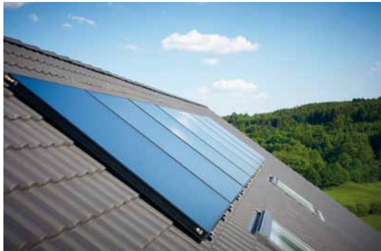
Pločasti kolektori montirani na kosi krov
